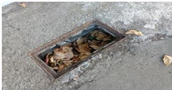
1. 排水溝裡的落葉清掉
