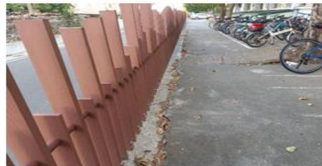
3. 圍欄與水泥地之間落葉清乾淨
